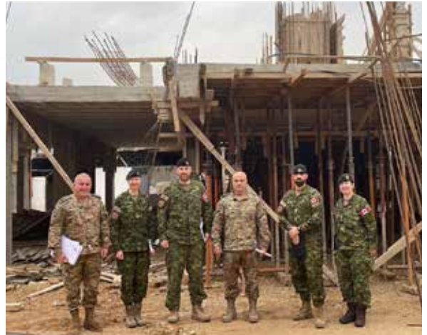
Visite du site du projet de construction de l’école technique de la brigade logistique de l’Armée libanaise.
